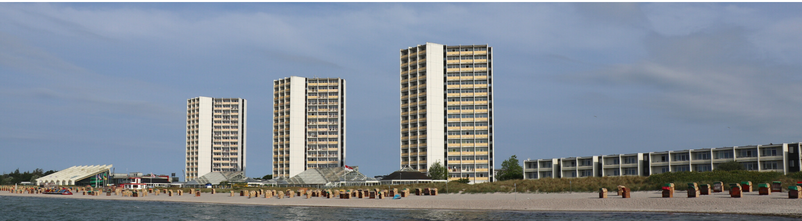
Burgtiefe Fehmarn Arne Jacobsen Otto Weitling 1968 1972 Gesamtansicht Meerwasserwellenbad Hotels Vitamar Suedstrand Meer 2 © Jan Dimog
